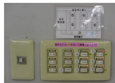
部分消灯しやすいように、電灯スイッチパネルに対象箇所を表示
