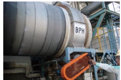
携帯用小型熱画像カメラによる熱ロス測定
