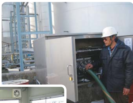
仮復旧のパイプライン
