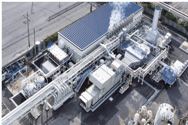
天然ガス等を利用し、発電時に発生する熱をエネルギーとして使用（名古屋工場）
