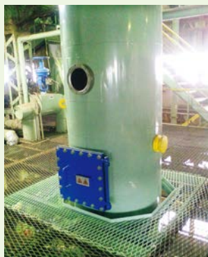
設備更新例：蒸留塔
