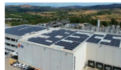
IQL(スペイン)の太陽光パネル
