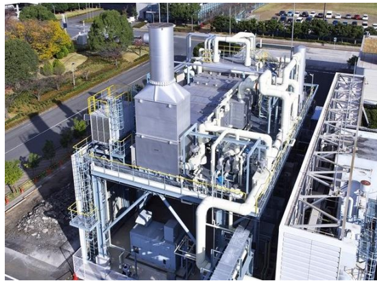
横浜磯子事業場に導入したコージェネレーションシステム
