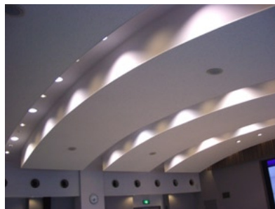
講堂の白熱電球をLED照明に更新。また屋外照明を水銀灯から長寿命省エネタイプ(メタルハライドランプ等)に更新しました。
