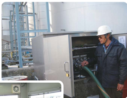
仮復旧のパイプライン
